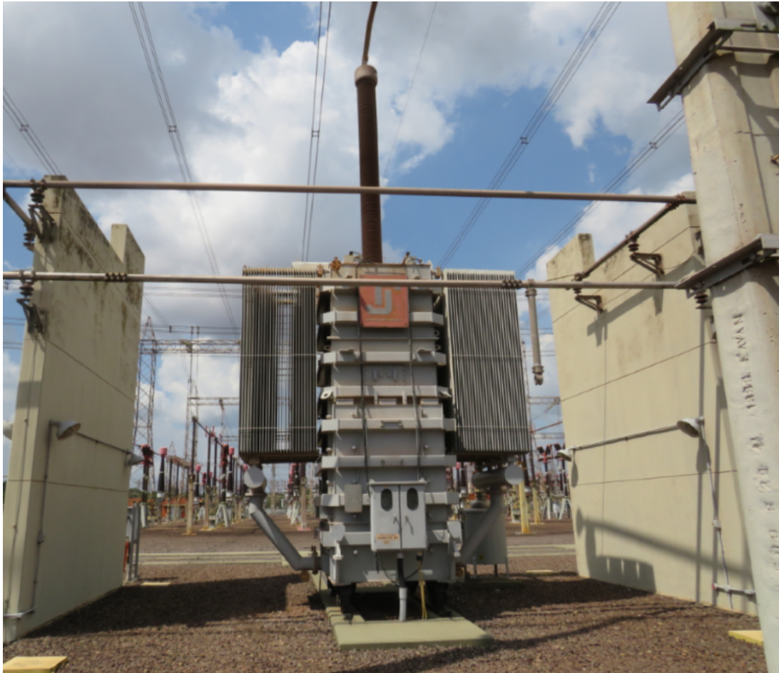
Figura 2 – Reator de 230 kV da Eletronorte (Fonte: Autor)
